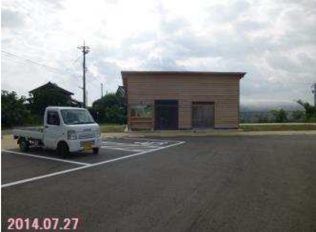
完成した資料棟 トイレ、作業場はこれから・・・
