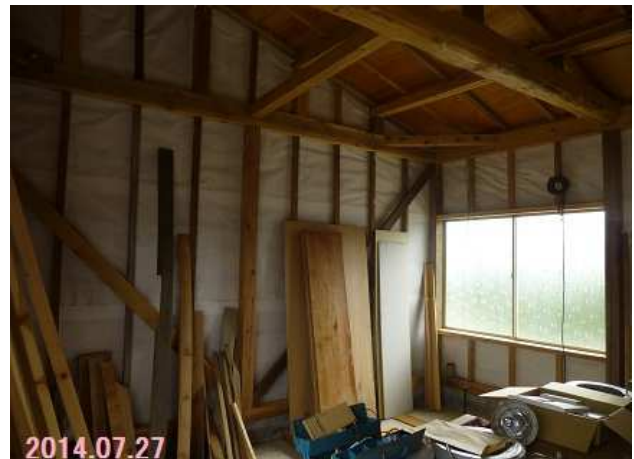
作業所は徐々に仕上げる予定
